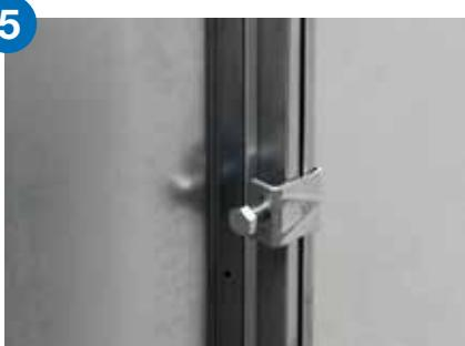
Na příruby RJFPC3 namontujte svorku čtyřhranného spoje RJBC. Pro zachování třídy těsnosti C celého systému je pro délku hrany větší než 400 mm nutno použít ke stažení přírubových profilů c svorky minimálně každých 200mm délky příruby.
