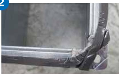
Nalepte těsnicí pásku (RJSM) na vnitřní plochu spojovacího profilu. Těsnicí pásky se musí v rozích křížit přes sebe viz obr.2.
