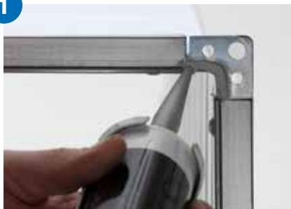
Naneste tmel na zapuštěnou část rohovníku (RJCL) a na spoje rohovníku a přírubové lišty RJFPC3 viz obr.1.
