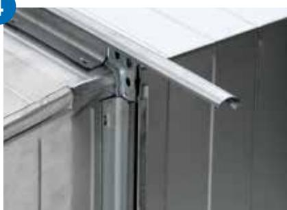
Na sešroubované přírubové profily namontujte nasunutím spojovací lištu RJSP ze strany potrubí. Pro přírubovou lištu RJCL20 a RJCL30 se používá shodný profil spojovací lišty RJSP2030, pro RJCL40 profil RJSP40.
